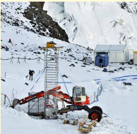
Pelle-araignée sur le chantier à 3 200 mètres d'altitude
