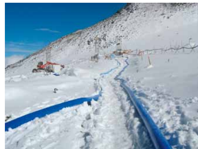
Le chantier courant septembre 2010.
